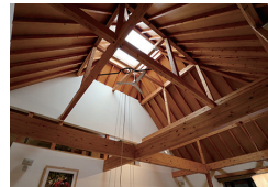
デイルーム天井見上げ
