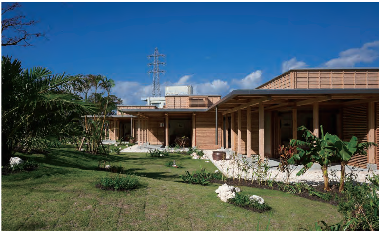
南東側外観 撮影者：木田勝久／FOTOTECA
