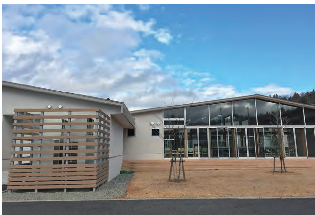
正面入り口から作業訓練室を見る
