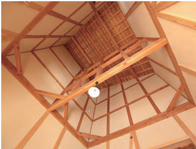
小屋裏まで土壁湿式工法を採用している
