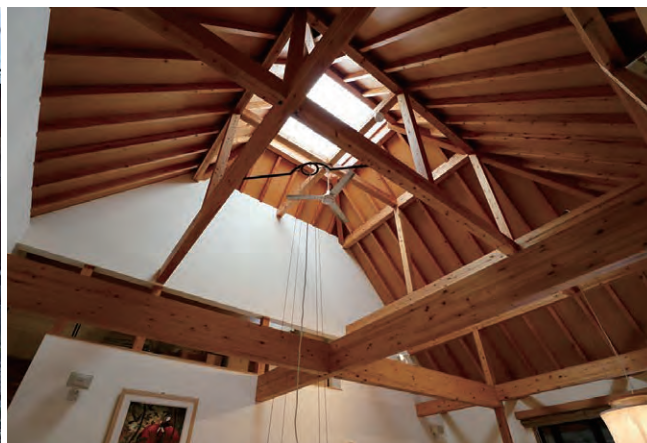
デイルーム天井見上げ【病棟】
