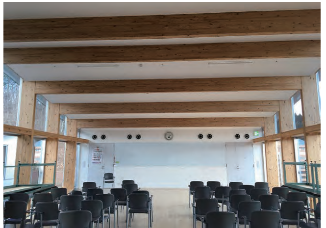
大断面集成材を用いた門型フレームによる大空間
