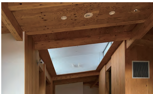
居室前の廊下天井
