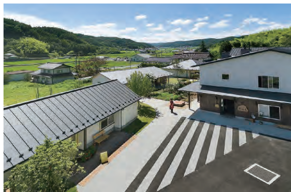
周辺の建物と大きさや外観を合わせて景観を保護する
