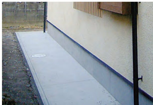
基礎周囲の犬走り
