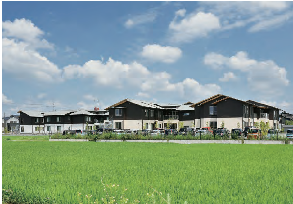
西側から西棟、北棟を見る
