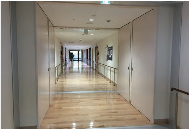
防火戸を設けた鉄筋コンクリート造の渡り廊下
