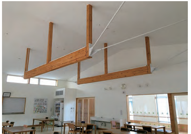
山型の梁を用いたサスペンション工法による大空間
