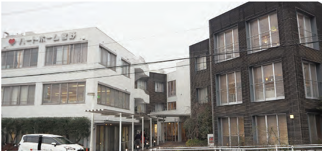
東側から施設全体を見る
