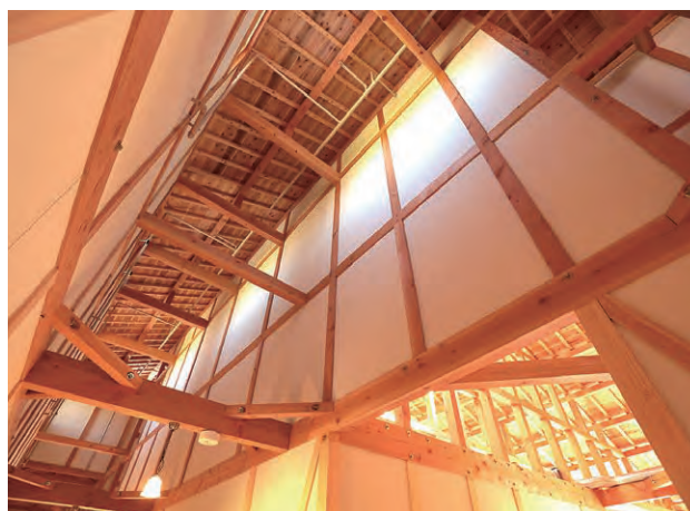
廊下から小屋裏を見上げる
