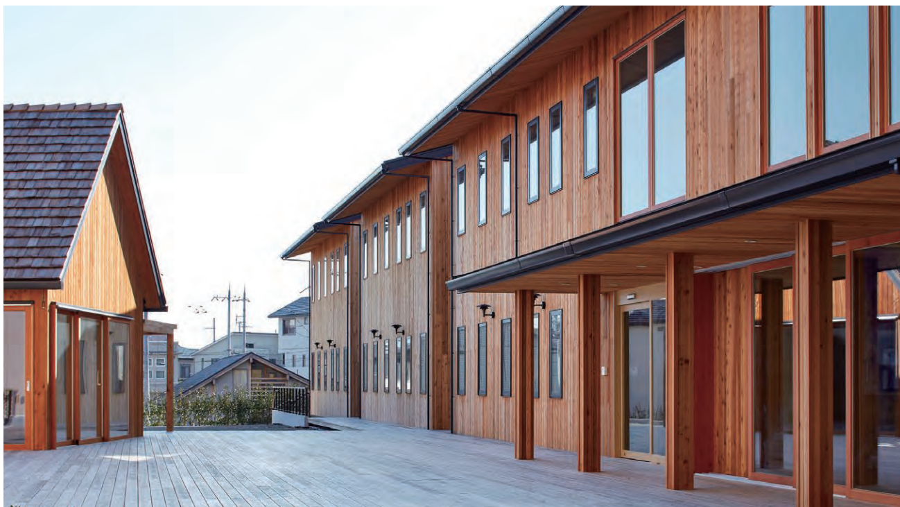
既設棟方向から①アネックス棟(右)、②付属棟(左)を見る
