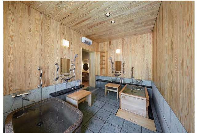
①浴室の床には濡れても滑りづらい十和田石を使用している
