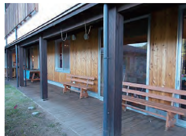
①雨の掛かりにくい縁側の板壁
